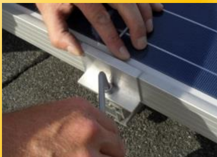
3. Modul einlegen und befestigen
