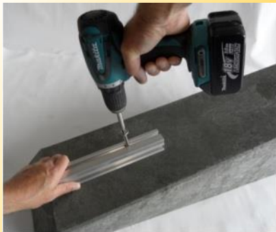
1. Montageschiene festschrauben
